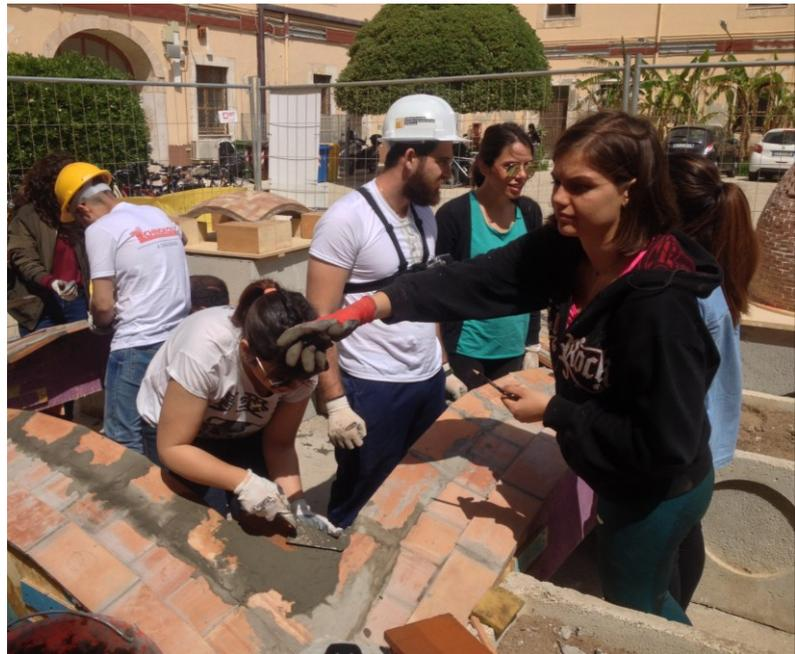
***BTV – Brick Tiled Vault – Volte funicolari sottili in laterizio*** è un progetto di ricerca che vede gli studenti della Struttura Didattica Speciale di Architettura - Università degli Studi di Catania – impegnati a realizzare in scala 1:1 un sistema costruttivo *low-tech*. Archi, volte e cupole in laterizio sono gli elementi costruttivi con cui gli allievi hanno sperimentato le potenzialità d’uso innovativo di materiali e tecnologie tipiche della tradizione costruttiva mediterranea.
