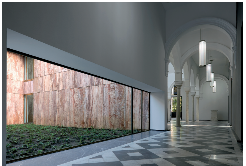
Recupero del Palazzo di San Telmo, sede della Presidenza della regione Ansalusia/Restoration of the San Telmo Palace, headquarters of the Presidency of the Andalusia Region
